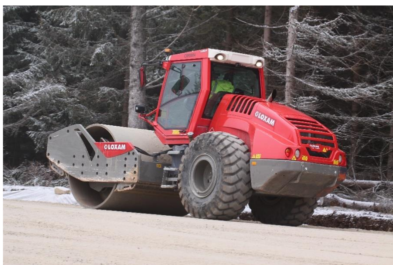
Photographie 83. Création des voiries
