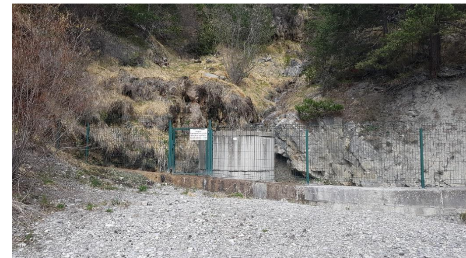
Photographie 9. Captage du torrent des Péous
