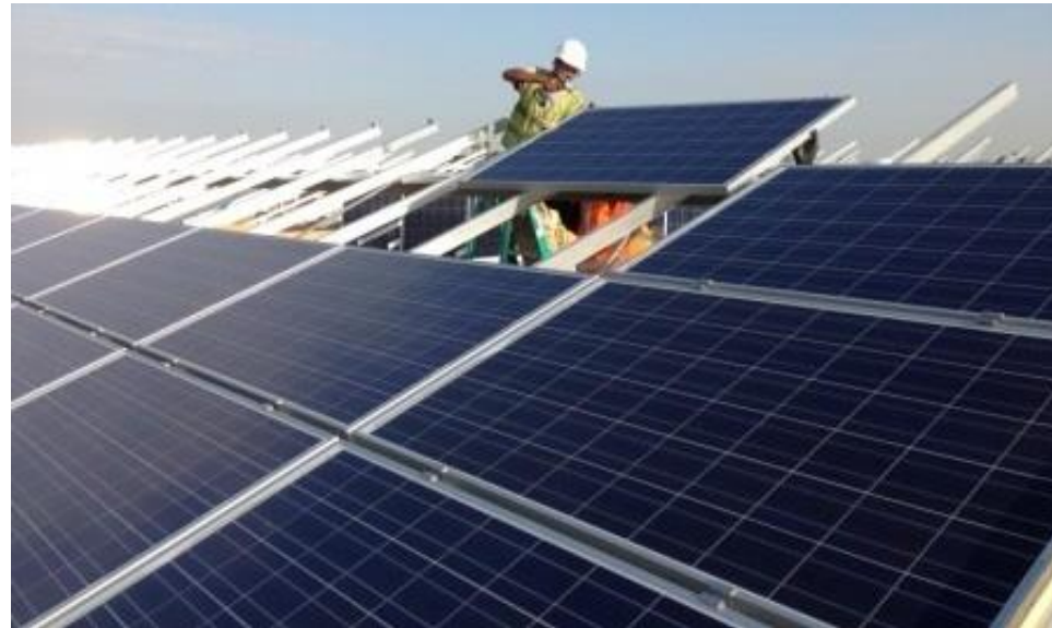
Photographie 72. Exemple de mise en place des panneaux sur les structures
