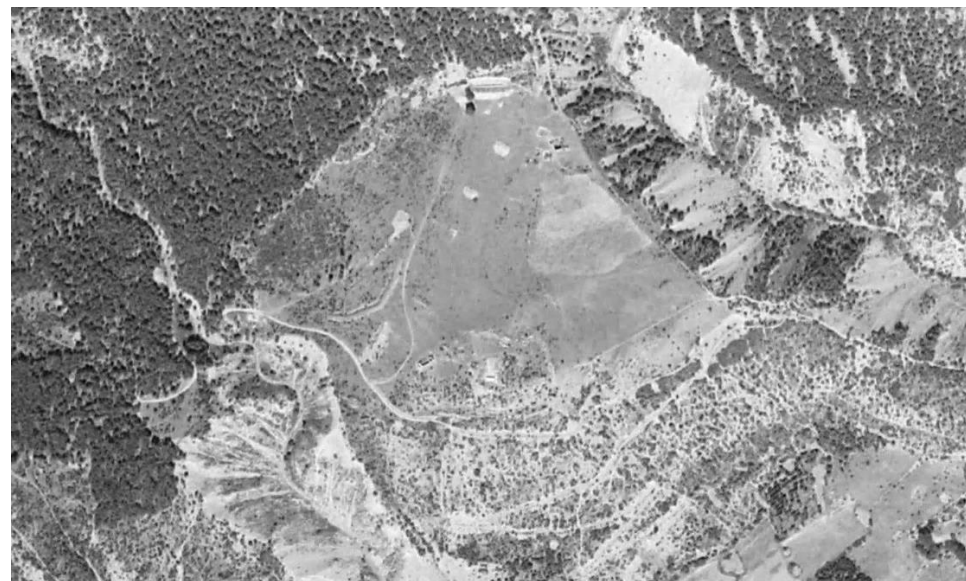
Photographie 3. Vue aérienne de 1948
