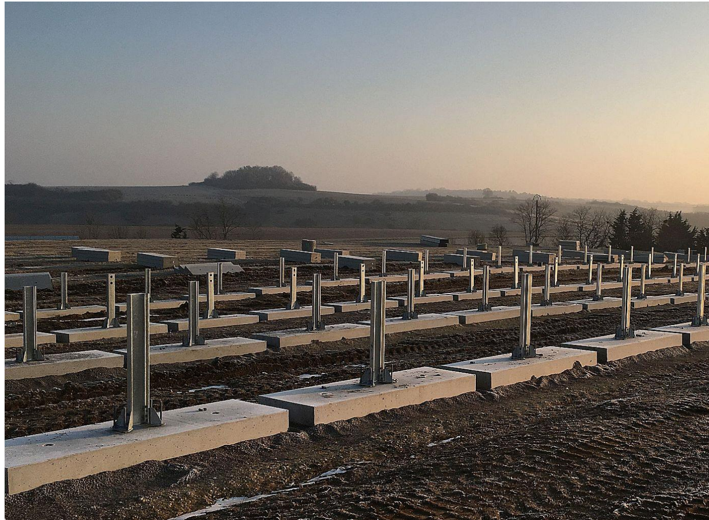
Photographie 63. Exemple de fondations béton - le maître d'ouvrage
