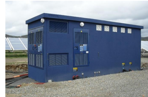
Photographie 64. Exemples d'onduleurs et transformateur installés dans des postes béton et containers
