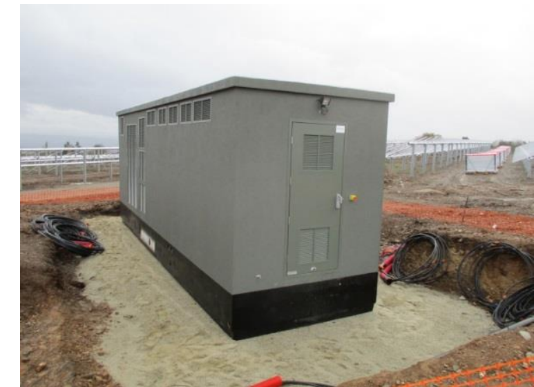
Photographie 74. Installation d'un poste électrique
