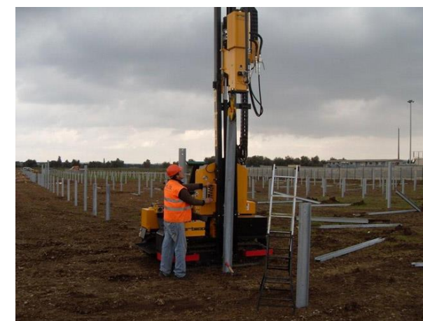
Photographie 61. Exemple de fondation type pieu
