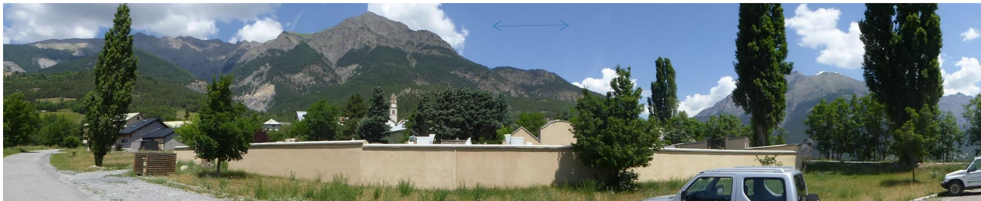
Photo 38 - hameau les Sanières au sud de Jausiers, à proximité de l'église et du cimetière le versant ouest incluant le secteur d'étude est visible.
