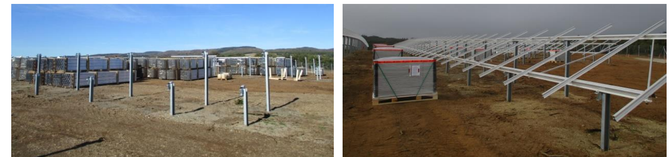
Photographie 71. Assemblage des structures sur site
