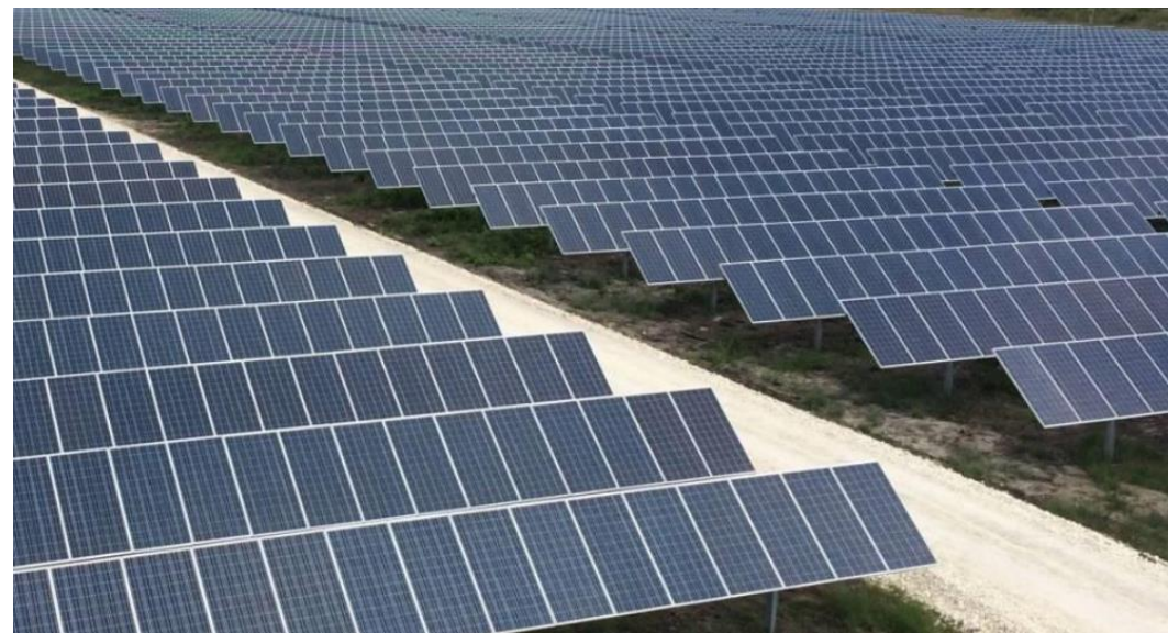
Photographie 69. Exemple de pistes empierrées
